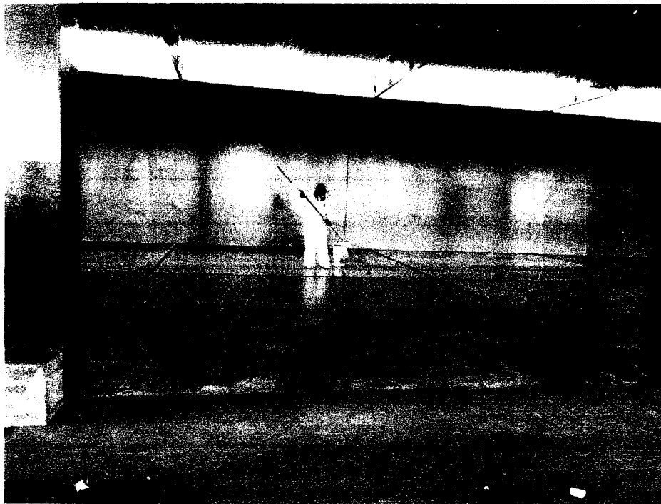
IMAGEN 03 Pintado de losa lado izquierdo 2da. mano
